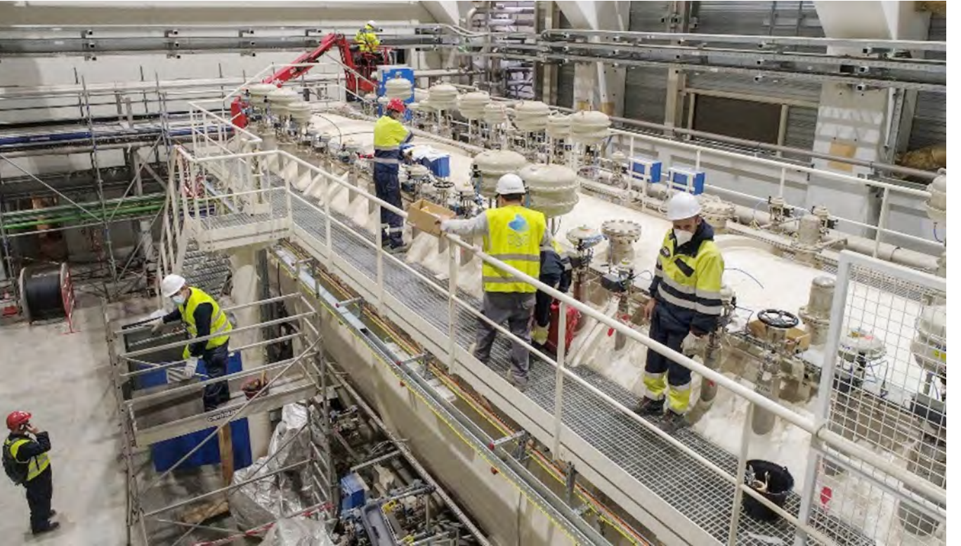
चित्र B.6. 20 मीटर लंबे 3.5 मीटर व्यास 70 टन क्रायोप्लांट टर्मिनेशन कोल्ड बॉक्स (सीटीसीबी) की स्थापना
