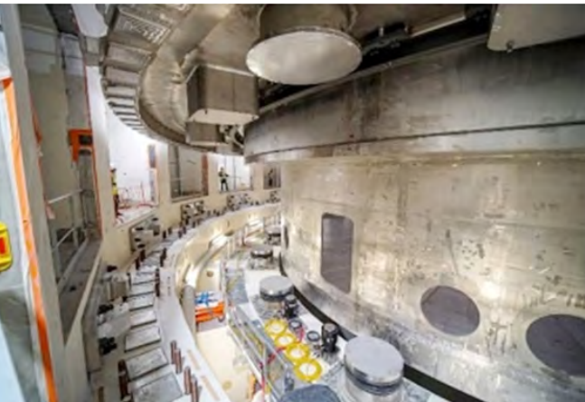
चित्र B.3 क्रायोस्टेट बेस सेक्शन को टोकामैक गड्ढे में वांछित स्थितीय सटीकता के साथ रखा गया।
