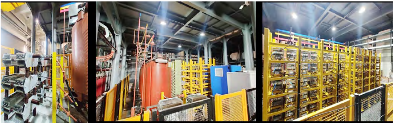
चित्र B.11. 55kV, 6MW MHVPS इटर-इंडिया पावर सप्लाय लैब में स्थापित
