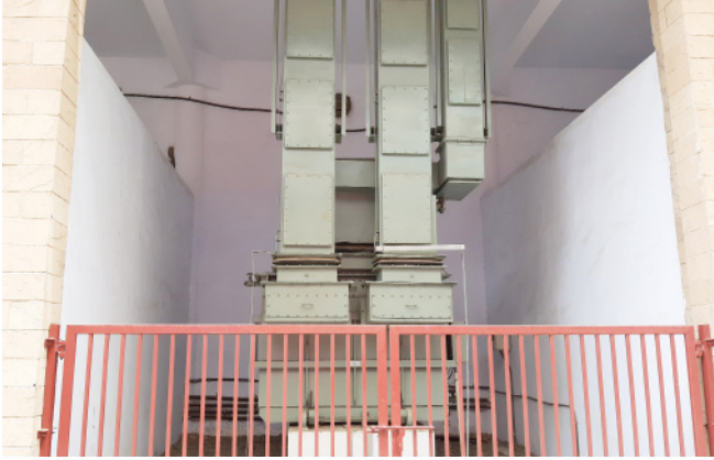
चित्र A.3.5 एसएसटी-1 के टोकामक हॉल के भीतर एसएसटी-1 पोलोइडल फील्ड (PF) कॉइल्स के लिए बिजली की आपूर्ति को कमीशन किया गया है। बाएं - ट्रांसफार्मर और दाएं - पीएफ कॉइल से बसबार कनेक्शन
