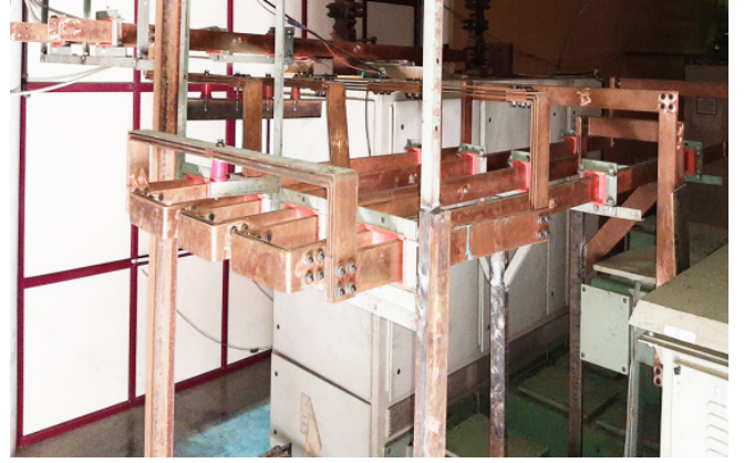
चित्र A.3.5 एसएसटी-1 के टोकामक हॉल के भीतर एसएसटी-1 पोलोइडल फील्ड (PF) कॉइल्स के लिए बिजली की आपूर्ति को कमीशन किया गया है। बाएं - ट्रांसफार्मर और दाएं - पीएफ कॉइल से बसबार कनेक्शन
