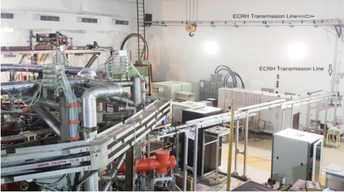
चित्र A.3.3 एसएसटी-1 हॉल से आदित्य अपग्रेड टोकामॅक तक ईसीआरएच पावर चालू करने के लिए ~75 मीटर लंबी ट्रांसमिशन लाइन का उपयोग किया गया, जो 63.5 मीमी आईडी नालीदार वेवगाइड, बेंड, पोलराइजर, डीसी ब्रेक और बेलोस आदि से युक्त है।
