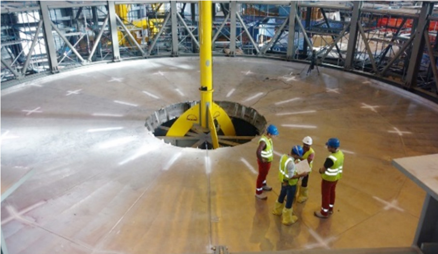
चित्र B.2 इटर साइट वर्कशॉप में क्रायोस्टेट बेस सेक्शन टीयर-1 की वेल्डिंग एवं परीक्षण
