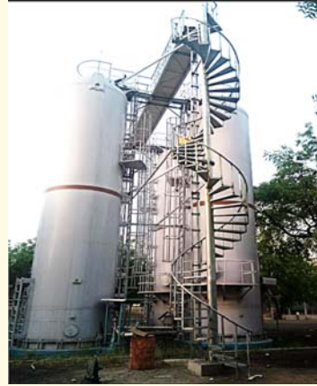
निर्मित सर्पिल सीढ़ी और संयुक्त प्लेटफार्म संरचना
