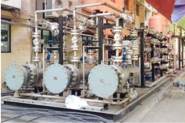
चित्र A.2.3 एचएचएफटीएफ के लिए उच्च दाब उच्च तापमान जल संचरण प्रणाली (एचपीएचटी-डब्ल्यूसीएस)
