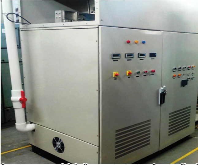
चित्र A.3.1.1 एलवीपीडी में नए 10kA/20V शक्ति आपूर्ति को स्थापित किया गया
