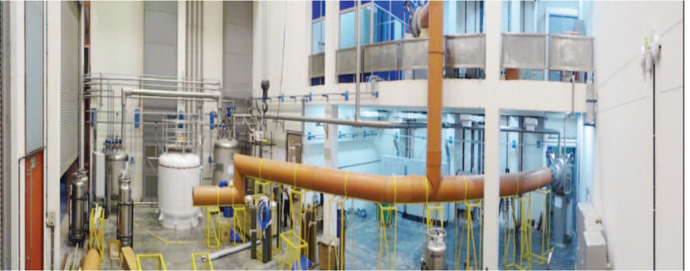
चित्र B.2.4 ईटर-भारत प्रयोगशाला में प्रोटोटाइप क्रायोलाइन (पीटीसीएल) परीक्षण आधारभूत संरचना
