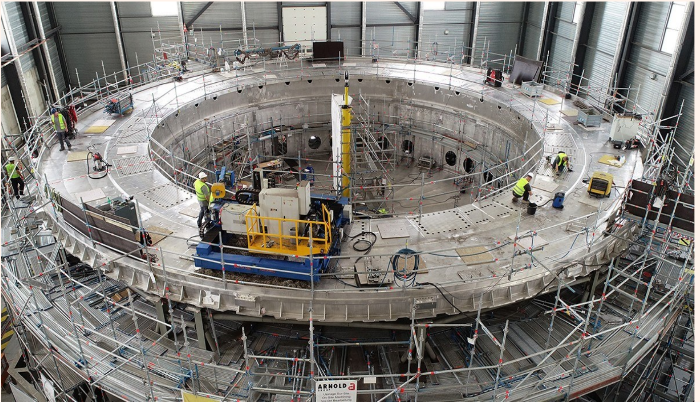
चित्र 5: क्रायोस्टेट के आधार खंड का निर्माण। पूर्वनिर्मित चित्र 5: क्रायोस्टेट के आधार खंड का निर्माण। 1,000 टन से अधिक वजन और 30 मीटर व्यास वाले पूर्वनिर्मित हिस्सों को भारत से भेजा गया, ताकि इस खंड को ईटर निर्माण स्थल पर वर्कशॉप में संयोजित किया जा सके।
