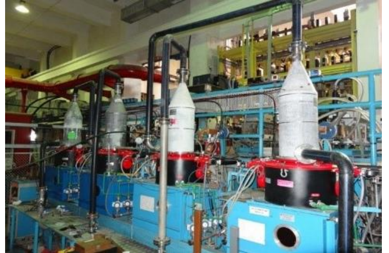
चित्र-2: एचपी एलएचसीडी स्रोत प्रणाली, जिसमें चार क्लाइस्ट्रॉन शामिल हैं, प्रत्येक को 3.7 गीगाहर्ट्ज पर 0.5MW-CW आरएफ पावर के लिए रेटड
